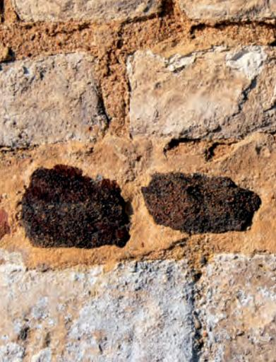
Un lit de grès roussard est intercalé dans l'appareil de tuffeau composé d'une assise de pierre de taille et de moellons au-dessus. Un joint de chaux et de sable coloré lie l'ensemble.
