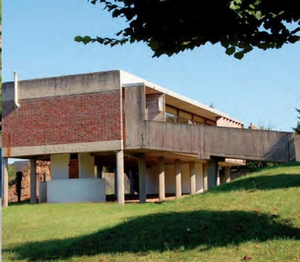
La cantine scolaire de Marçon a été réalisée entre 1959 et 1961. Y sont illustrés les “5 points d’une architecture nouvelle”, principe fondateur du Mouvement Moderne : toit terrasse, pilotis, plan libre, façade libre et fenêtre en longueur.
